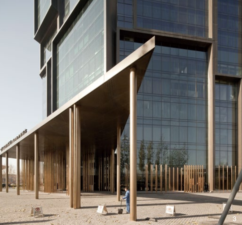
3. 多根銅桿支撐著兩個懸浮天蓬，引領訪客進入主入口。4. 西北向立視圖。5. 西向立視圖。6. 南向立視圖。7. 建築剖面圖。8.9.10. 中庭與露台。 3.A canopy supported by several copper columns give a direct hint of entrance ©Pegenaute 4.W.-N. side elevation 5.West elevation 6.South elevation 7.Section 8.9.10.Courtyard and balcony views©Pegenaute
