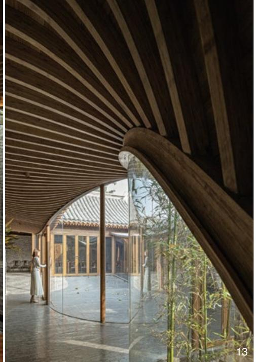
12. 遊廊延續屋頂的曲面線條，結合前後院景觀進行相應的起伏。13. 遊廊採用框架結構支撐密肋梁與板，讓新結構通透輕盈地融入到舊建築裡。14. 剖面圖。15.16. 客廳區因透明遊廊與庭園彼此借景。
