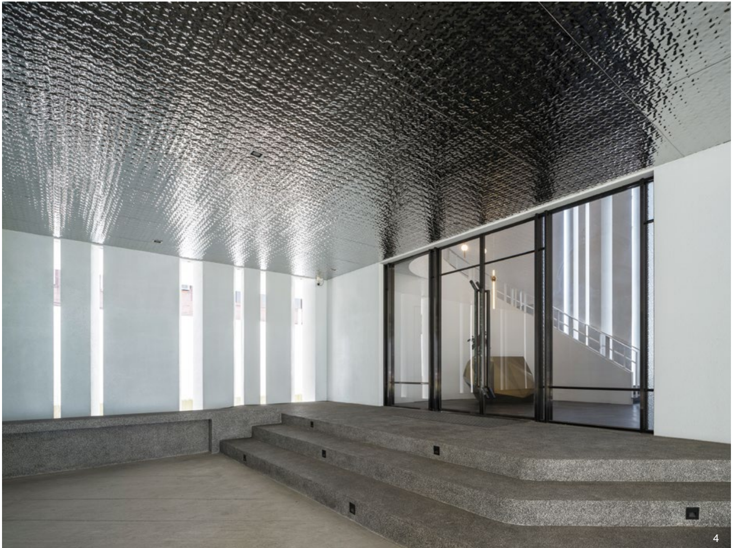
3. 1樓平面圖。4. 1樓迎賓外玄關天花板鋪覆水波紋不鏽鋼板，將水之意象植入其中。5. 用純淨設色突顯出建築結構，立面僅以燈帶作簡潔裝飾。6. 迎賓內玄關，挑高空間以旋梯蜿蜒而上。7. 旋梯造型與挑高空間，構成入內的初步印象。
